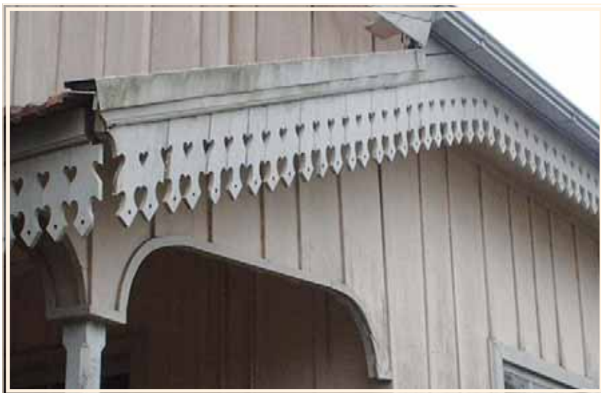
Charakterystyczny okap dachu z lambrekinem. Dom kolonisty polskiego w Rio Claro do Sul, PR
