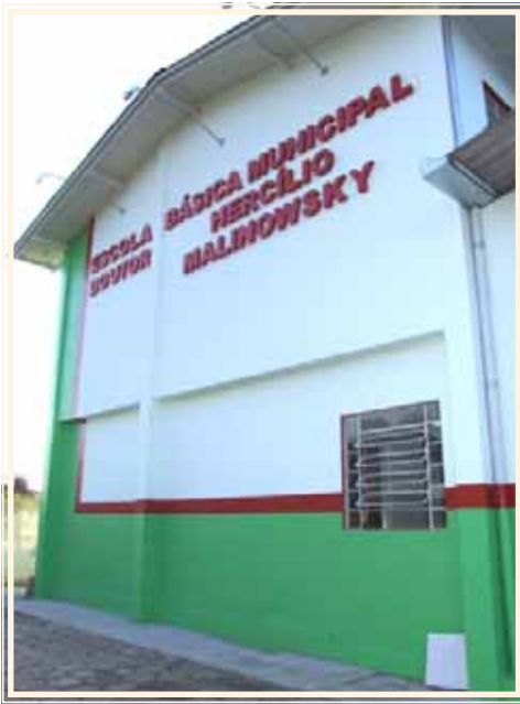
Szkoła podstawowa dra Hercílio Malinowskiego w municypium São Bento do Sul, SC Escola Básica Municipal Doutor Hercílio Malinowsky em São Bento do Sul, SC
