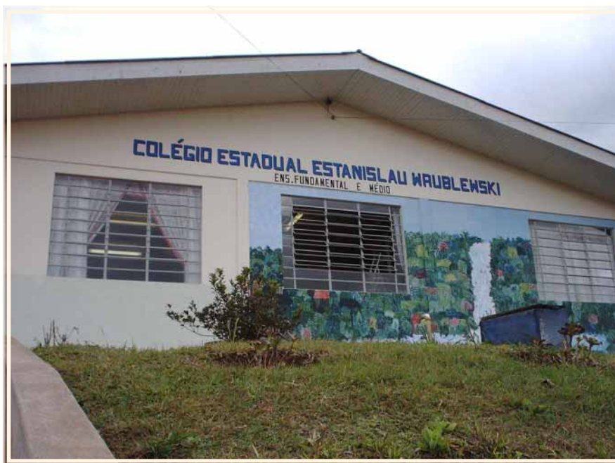
Fronton szkoły stanowej im. Stanisława Wrublewskiego w Santanie, PR Fachada do Colégio Estadual Estanislau Wrublewski em Santana, PR
